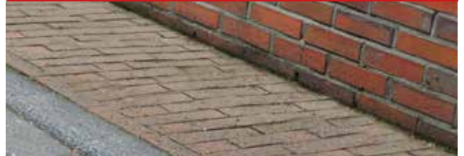
Oben: Grünbewuchs bis an die Kanten. Unten: Überzeugende, komplette Grünentfernung.
